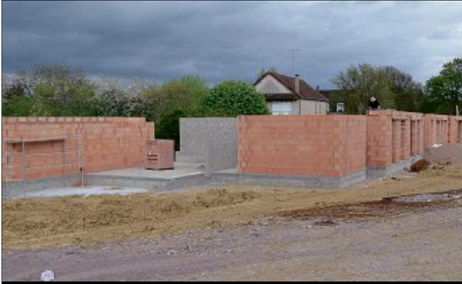
INVESTISSEMENT. La Maison de santé représente le plus important investissement de la nouvelle communauté de communes Tannay-Brinon-Corbigny.
