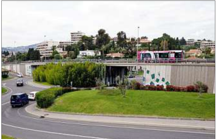
La RD 6107 reste trop bruyante selon les riverains qui cherchent des moyens pour réduire les nuisances. Mais ils ne savent plus à qui s'adresser. (Photo J.S. Gino Antomarchi)
